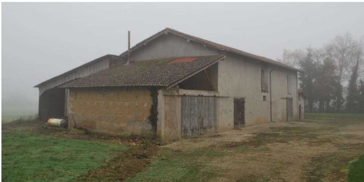
Bâtiment ajouté : « Le Bonnet »
